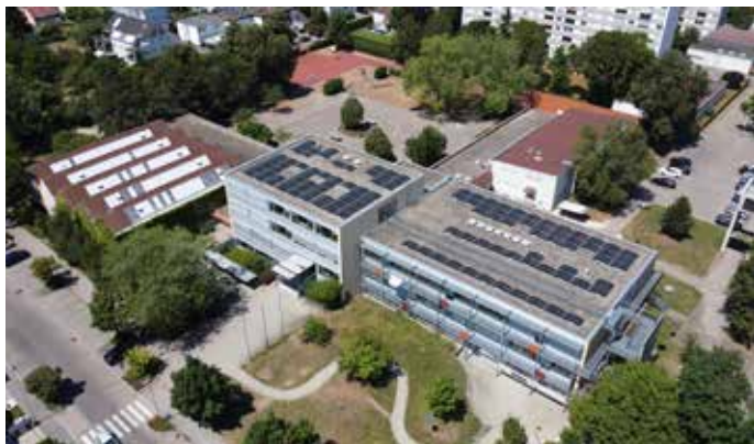
Die Anlage auf der Erich-Kästner-Schule in Neu-Ulm ging im August 2025 in Betrieb und liefert ca. 90.000 kWh Strom pro Jahr. Foto: Michael Osswald
