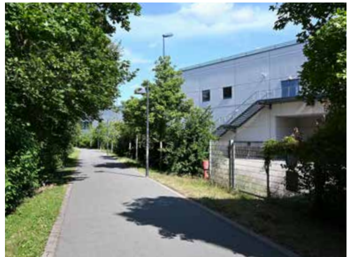
Die Umgestaltung des Blautalcenters soll so umweltfreundlich wie möglich sein. Aus diesem Grund werden Teile der vorhandenen Betonskelettstruktur erhalten und die kleine Blau (versteckt in den Büschen links) mit einer Uferpromenade aufgewertet. Foto: Stefan Loeffler
