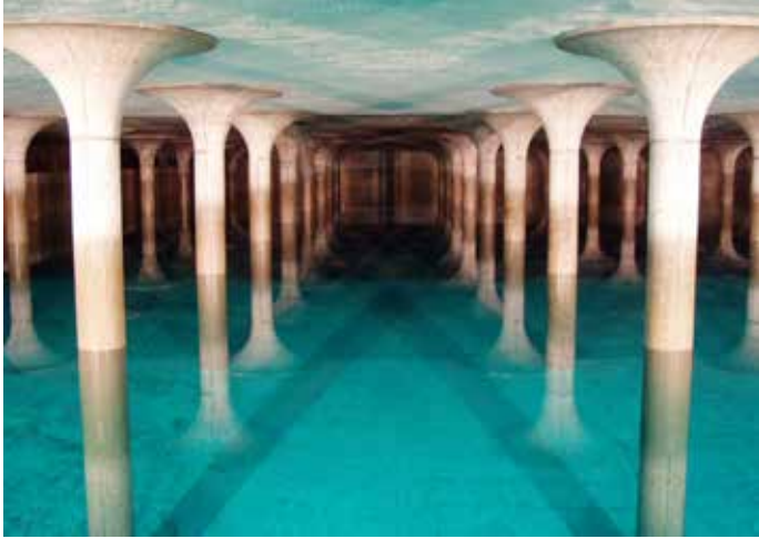
Wasserbehälter in Amstetten. (Bild: Landeswasserversorgung Stuttgart)
