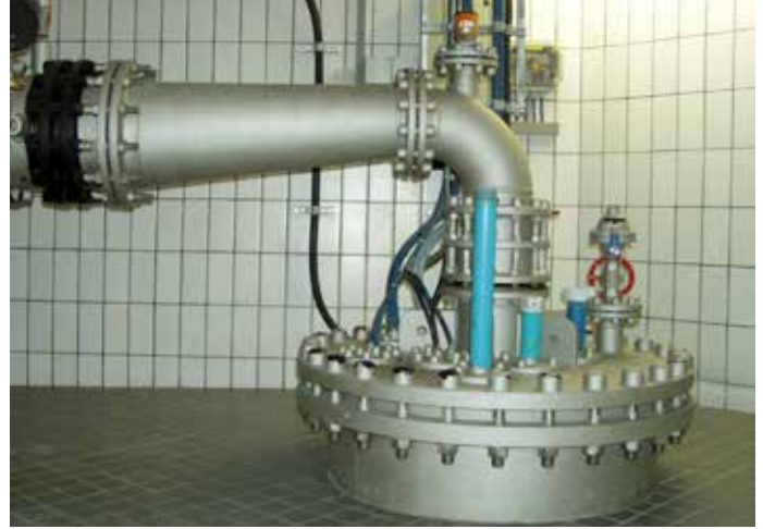
Wasserwerk mit Tiefbrunnen. (Bild: Landeswasserversorgung Stuttgart)
