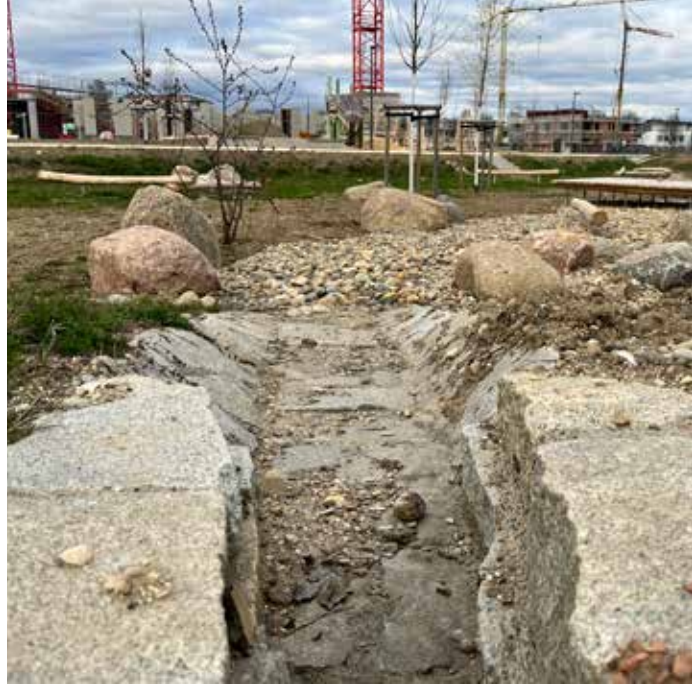
Im Neubaugebiet „Wohnen am Illerpark“ wird Regenwasser über eine Rinne auf einen tiefer liegenden Spielplatz geleitet, der als Rückhaltebecken dient.
